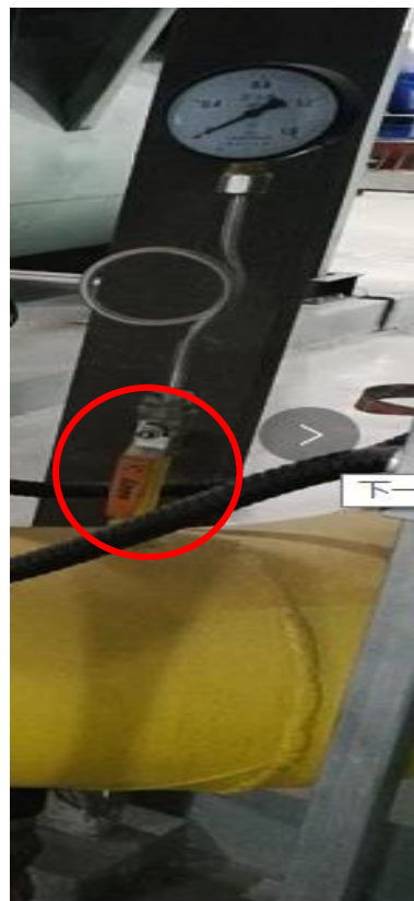
管路中的流量计、压力表装错位置与漏装等
