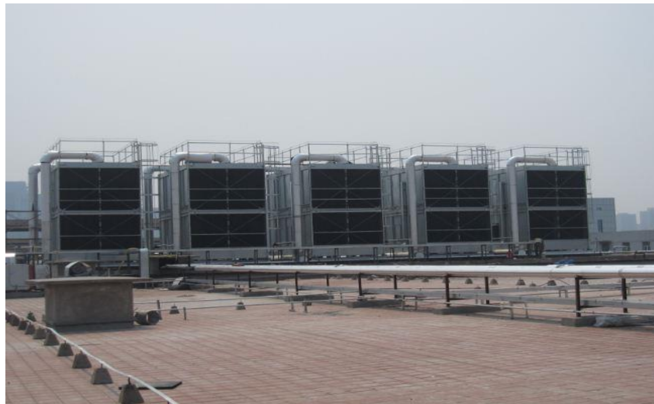
屋顶最高点缺少相应的避雷装置
